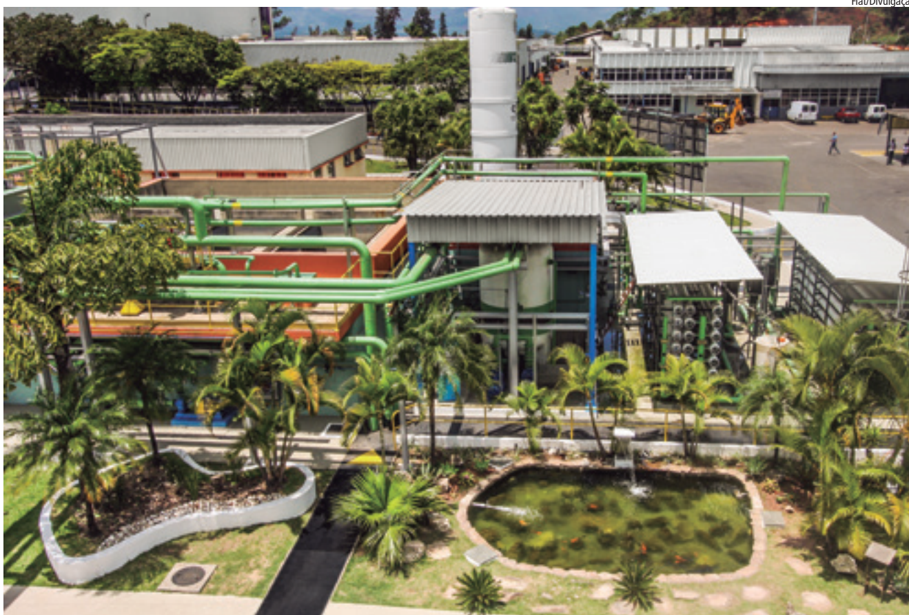
O Complexo de Tratamento de Efluentes Líquidos construído na fábrica da Fiat, em Betim, permite o reuso de 99% da água utilizada pela montadora em sua produção
