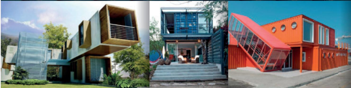
Os containers, caixa de chapa utilizada como meio de transporte marítimo, vêm sendo adaptados para seu reúso na arquitetura com apelos moderno e econômico.
