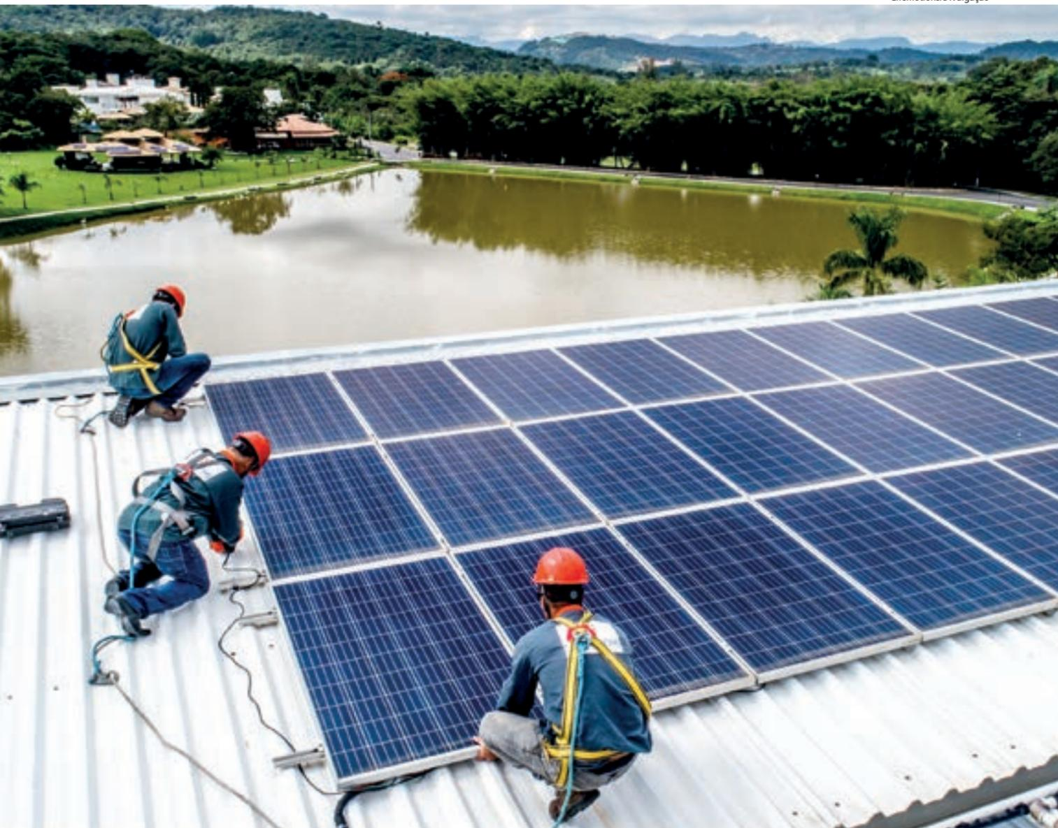
Painéis são instalados no telhado para captarem a luz solar, e um inversor torna a energia absorvida compatível com a rede elétrica
